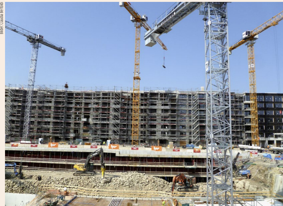
Die Gebäude der ersten Bauetappe, hier der Neubau mit 160 Mietwohnungen, befinden sich bereits in der Ausbauphase.
