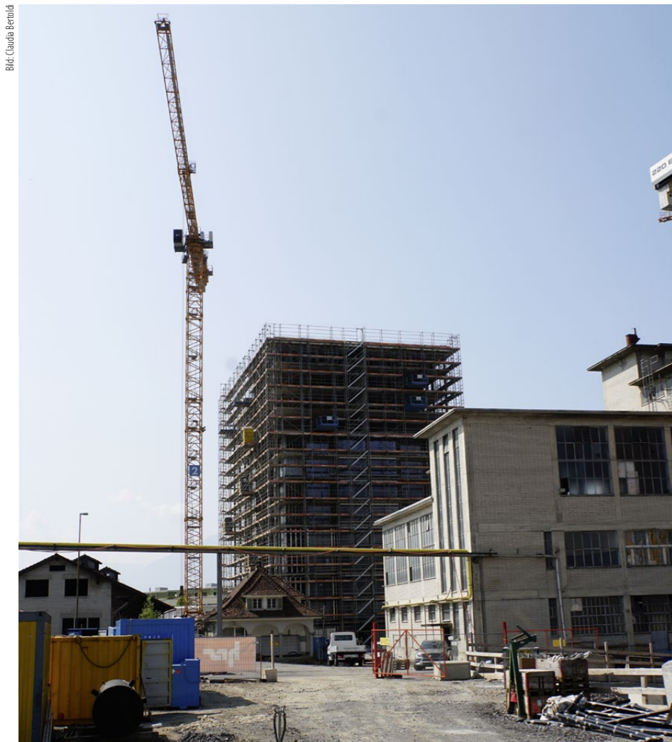
Mit dem südlichsten Hochhaus des Papieri-Areals wurde das Grossprojekt gestartet. Das davorliegende Kesselhaus wird für gewerbliche Zwecke umgebaut.
