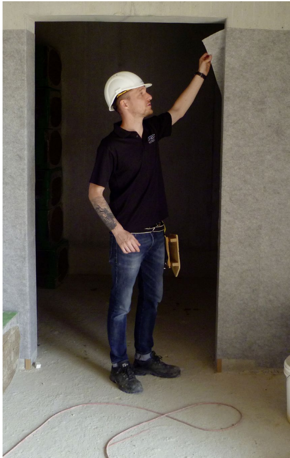
Sichtbetonflächen müssen in der Bauphase vor Verschmutzungen und Beschädigungen geschützt werden. Ein selbstklebendes Schutzvlies erweist sich dafür als ideale Lösung.
