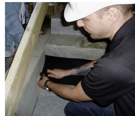
Die Kunststoff-Profile mit Abkantung werden mit dem Cutter auf die benötigte Länge geschnitten.
