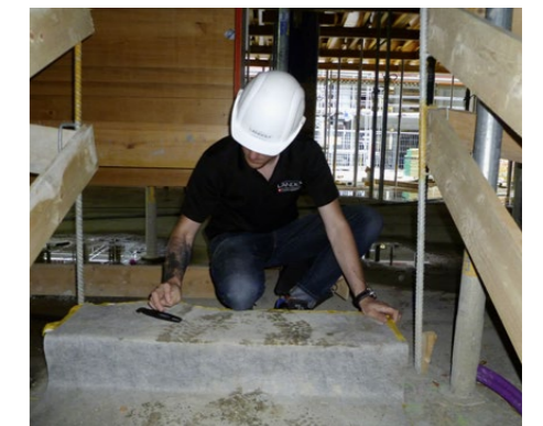
Das Schutzvlies wird über die Profile geklebt. Die leichte Platte haftet fest an den Treppenstufen.
