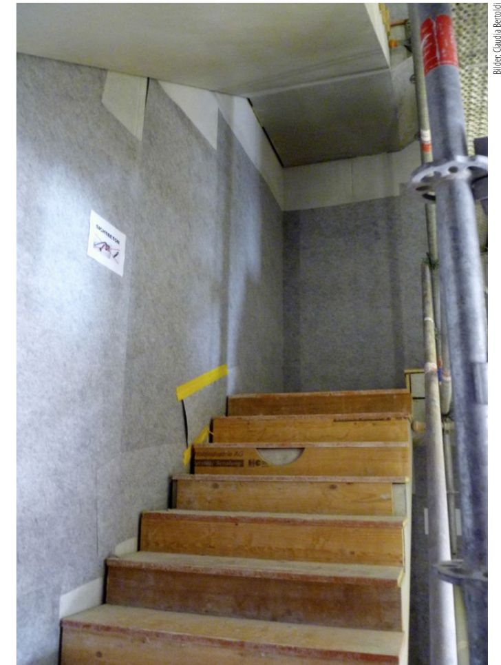
Das Vlies an den Wänden der Treppenhäuser schützt vor Schäden beim Materialtransport in der Bauphase, später beim Möbeltransport.
