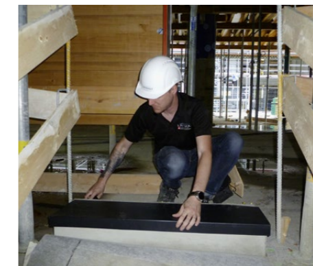
Das leichte Kunststoffmaterial wird angepasst und bündig mit der Stufenkante aufgelegt.
